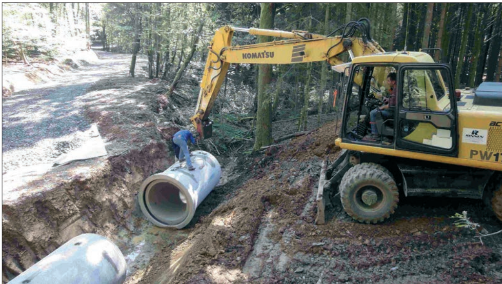
Abb. 11: Einlegen eines Betonrohres mit 1200 mm Durchmesser
