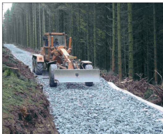
Abb. 9: Einbauen anhand eines Graders
