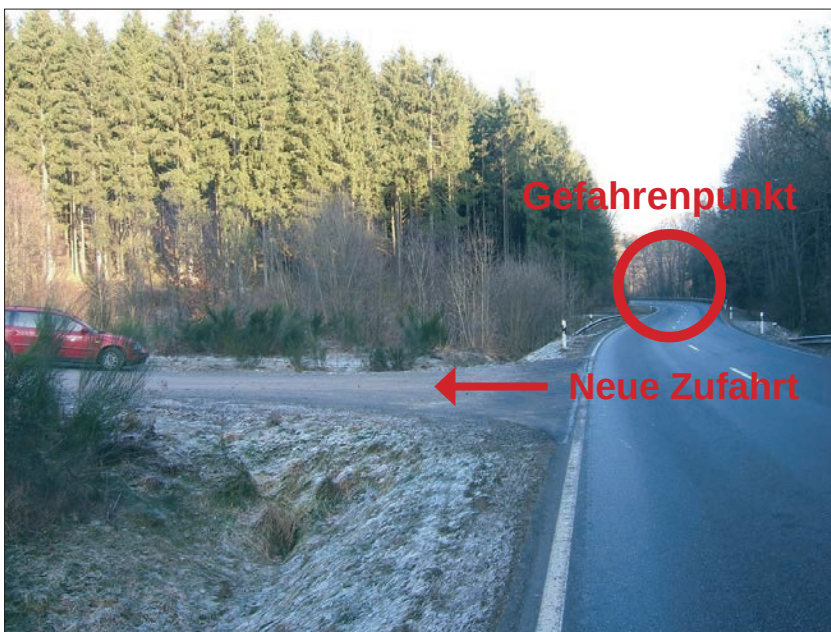
Abb. 17: Entschärfung des Verkehrsgefahrenpunktes durch Verlegung der Zufahrt
