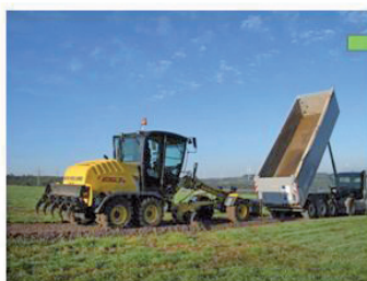
Schüttung der Tragschicht
