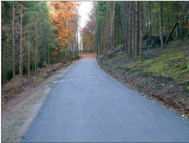
Abb. 3: Bau neuer Waldwege
