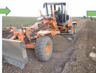
Ausgleichen der Tragschicht
