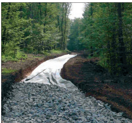
Abb. 8: Geotextil mit 20 cm Material 70/150
